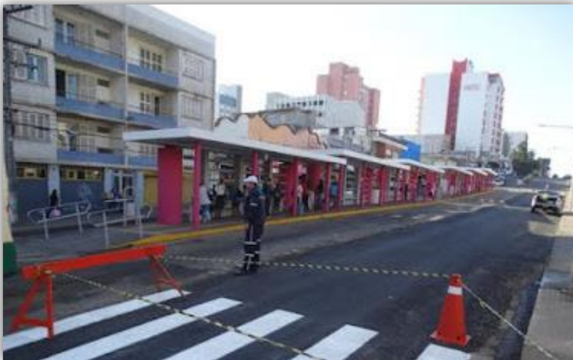
Terminal de Ônibus em sua última manutenção - 2017
