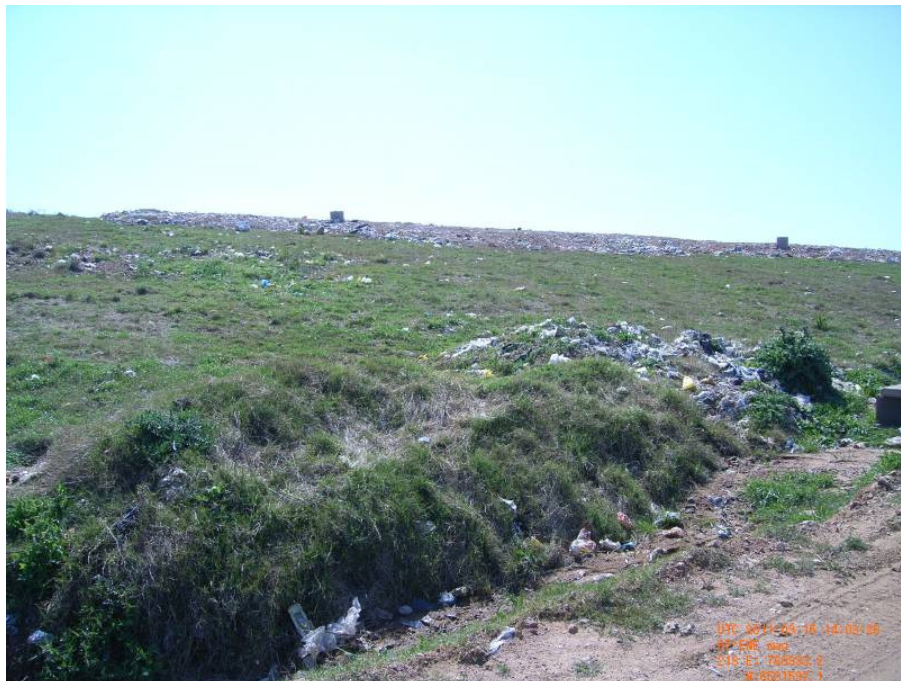
Foto 13 - Vista das condições atuais do Aterro Sanitário municipal de Bagé. Detalhe da célula 01 em processo de recuperação ambiental.
