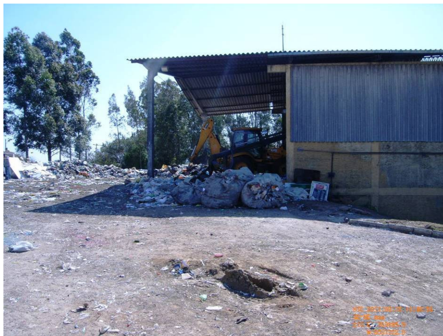
Foto 15 - Vista do pavilhão de chegada de resíduos urbanos na Central de Triagem de resíduos do município de Bagé .
