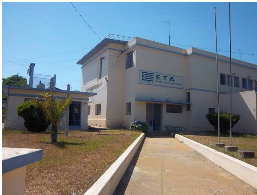
Foto 30 - Estação de Tratamento de água localizada na Rua Torquato Severo.
