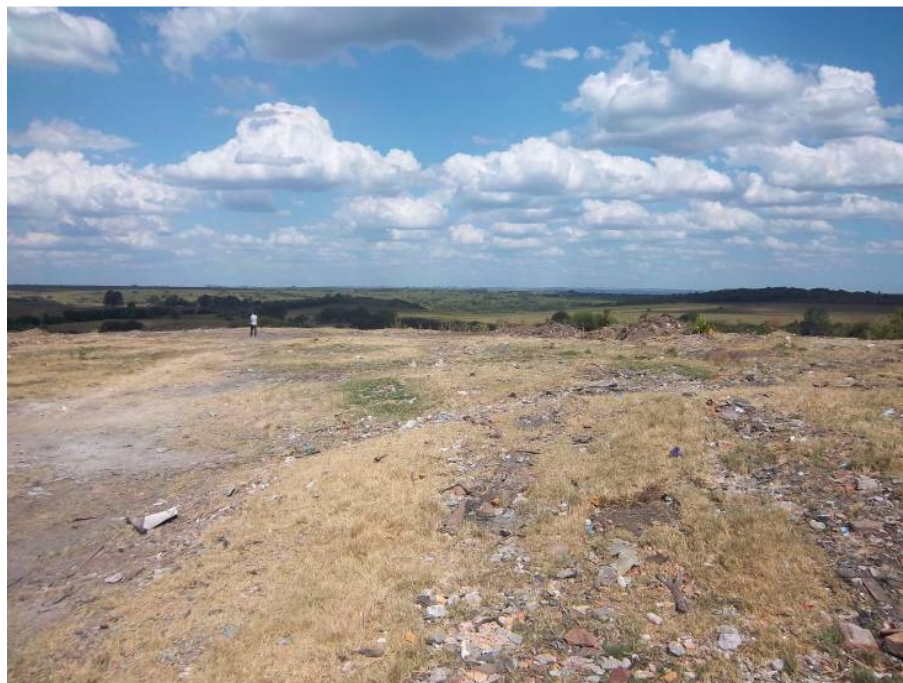
Foto 34 - Vista geral do Aterro desativado localizado na antiga pedreira esgotada.
