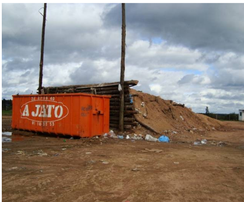
Foto 58 - Área de transbordo, com vista do contêiner de armazenamento dos RSU.
