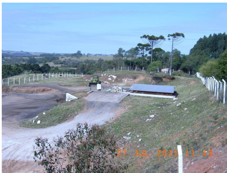
Foto 25 - Vista da estação de transbordo do município de Caçapava do Sul.
