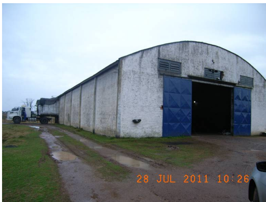
Foto 29 - Vista da área de transbordo do município de Dom Pedrito.
