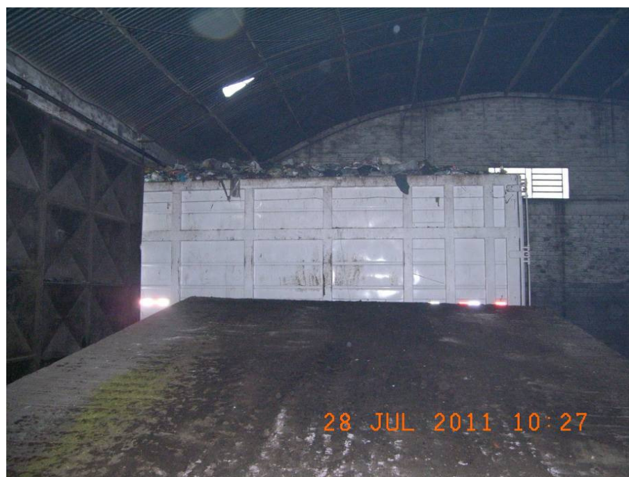
Foto 32 - Outra vista do galpão da área de transbordo, com destaque para a rampa de transferência de resíduos.
