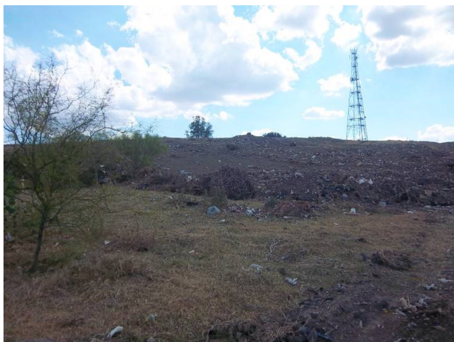
Foto 36 - Outra vista geral do Aterro desativado localizado na antiga pedreira esgotada.
