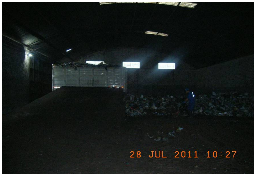
Foto 31 - Galpão em alvenaria coberto na área de transbordo de Dom Pedrito.
