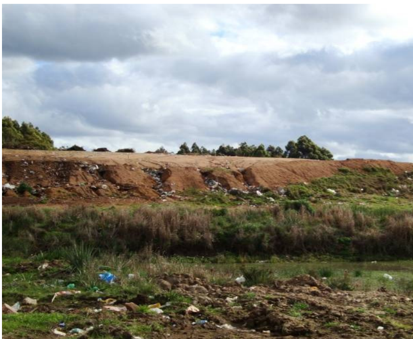
Foto 60 - Vista do aterro desativado e da lagoa de estabilização.
