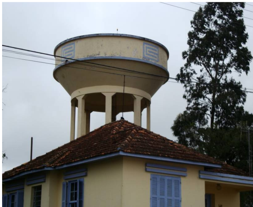
Foto 56 - Reservatório vinculado ao sistema de abastecimento de água do município de Pinheiro Machado
