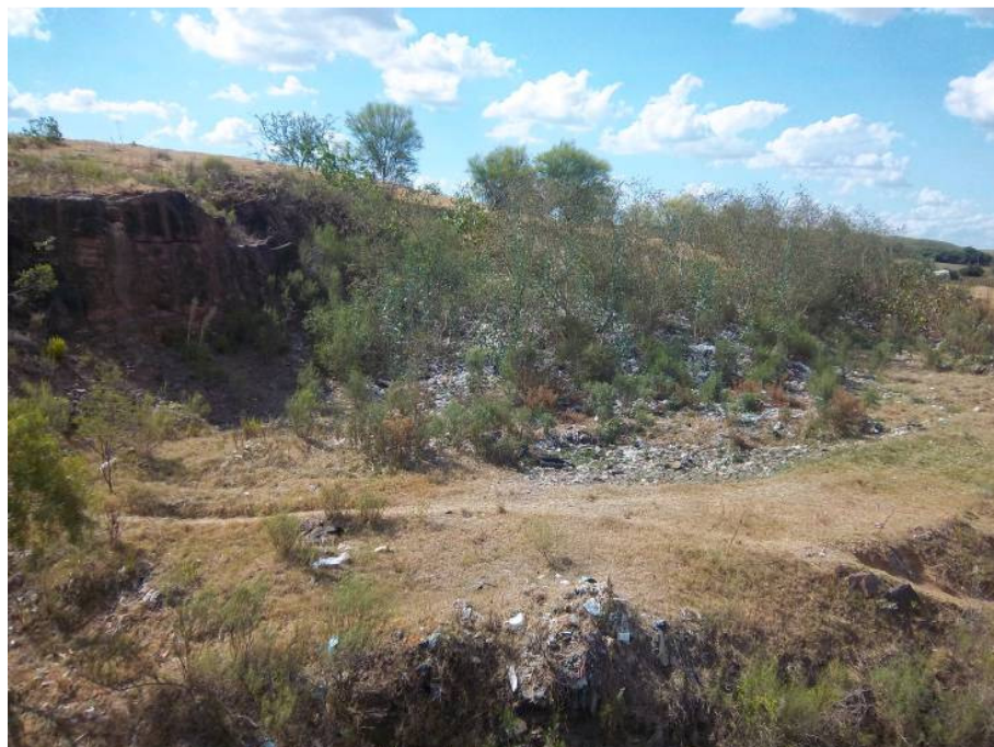
Foto 35 - Outra vista geral do Aterro desativado localizado na antiga pedreira esgotada.
