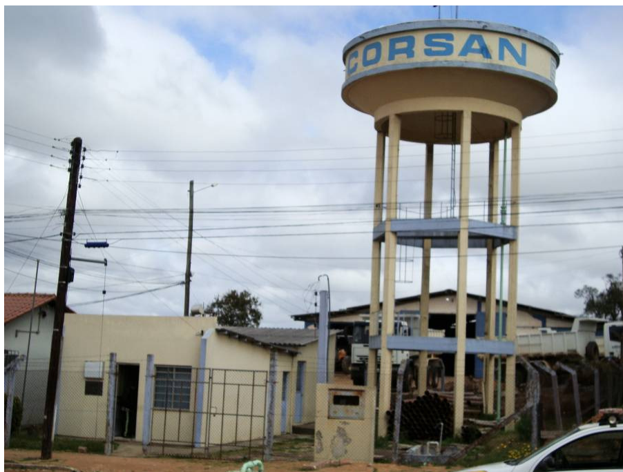
Foto 54 - Reservatório que compõe parte do sistema de abastecimento de água no município de Pedras Altas.
