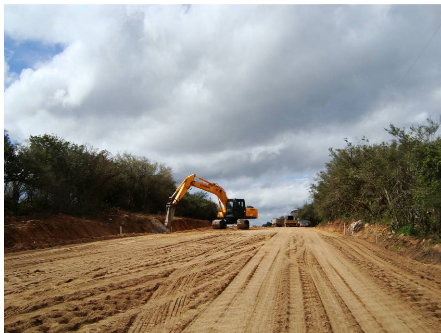
Foto 53 - Vista das condições atuais da rodovia federal ERS 608 em processo de pavimentação, principal acesso para o município de Pedras Altas.
