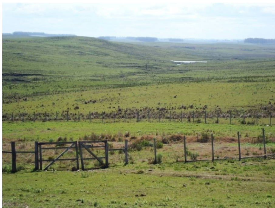
Foto 7 - Vista da antiga área de depósito de RSU recuperada, com cercamento.
