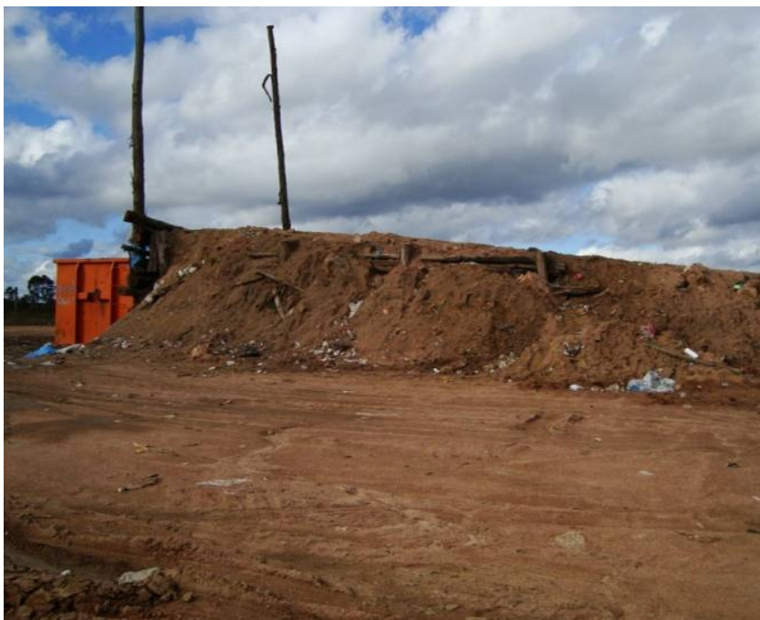
Foto 57 - vista da rampa de acesso da área de transbordo.
